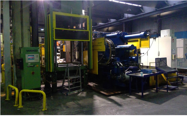
Pos. 68 1 Gießzelle DGM 21 1 Casting bay DGM 21
