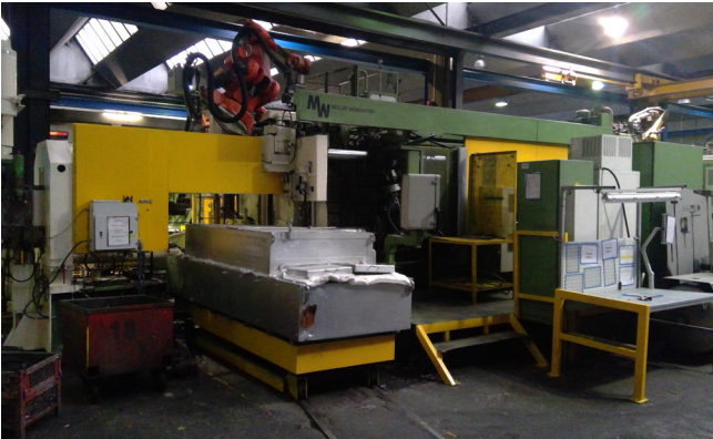
Pos. 70 1 Gießzelle DGM 18 1 Casting bay DGM 18
