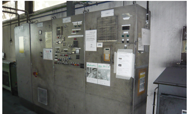
Pos. 375 1 Mischanlage Fabr. MTI, Typ EM 1600 GT 1 Mixing system MTI, model EM 1600 GT
