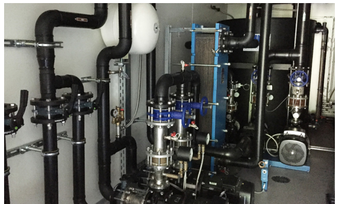
Pos. 560 1 Kälteanlage Hafner & Muschler, Bj. 2014 1 Cooling system Hafner & Muschler, manuf. in 2014
