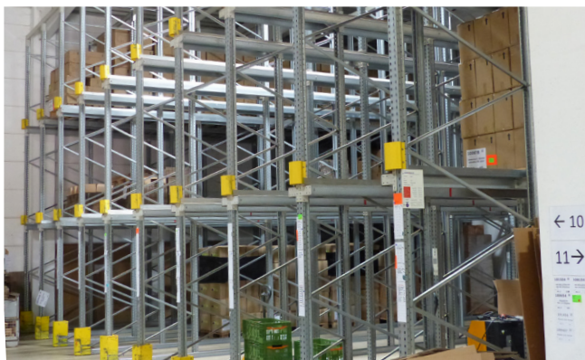
Pos. 38 1 Einfahrregalanlage Galler 1 Drive-in cantilever racking system Galler
