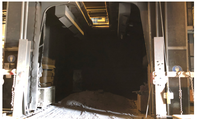
Pos. 384 1 Sandaufbereitung WEBAC, Bj. 2005-2007 1 Sand processing system WEBAC, YOM 2005-2007
