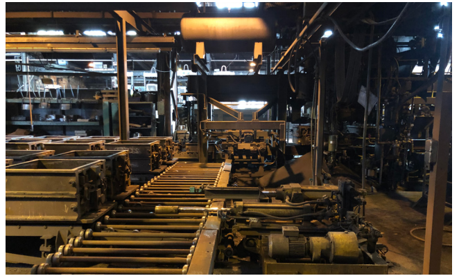
Pos. 377 1 halbautomatische Grünsand-Formanlage ZIMMERMANN SP3T1 1 Semi-automatic greensand moulding line ZIMMERMANN SP3T1
