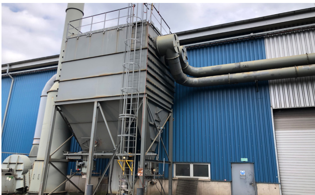
Pos. 34 1 Sandaufbereitungsanlage WEBAC, Bj. 2007 1 Sand preparation plant WEBAC, YOM 2007
